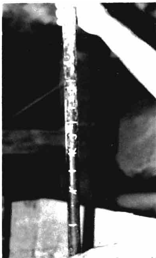
Fig. 39.—Regla del molinero de Maya para medir el contenido en grano de la tolva.
