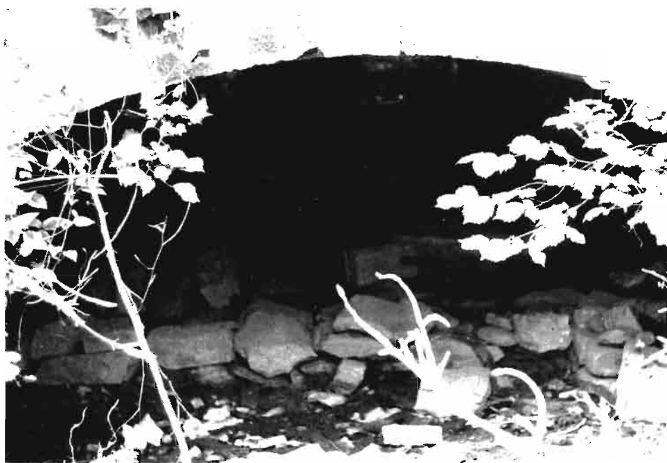
Fig. 28.—Desagüe general del molino de Zaldubia.
